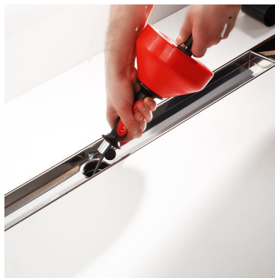
Odpadní potrubí čistíte pomocí malé manuální spirály
